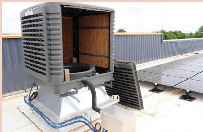
Quatre Adiabox, en cours de mise en service, procurent un rafraîchissement adiabatique : l'eau envoyée en partie haute grâce à une pompe à eau ruisselle sur un médium en fibre de cellulose alvéolaire qui favorise l'échange entre air et eau. Un ventilateur de 1 000 W "aspire" l'air extérieur, qui évapore l'eau contenue dans les fibres en passant au travers du médium et lui cède des calories. Le bâtiment bénéficie ainsi d'un air neuf et rafraîchi (sa température peut être abaissée de 8 °C).
