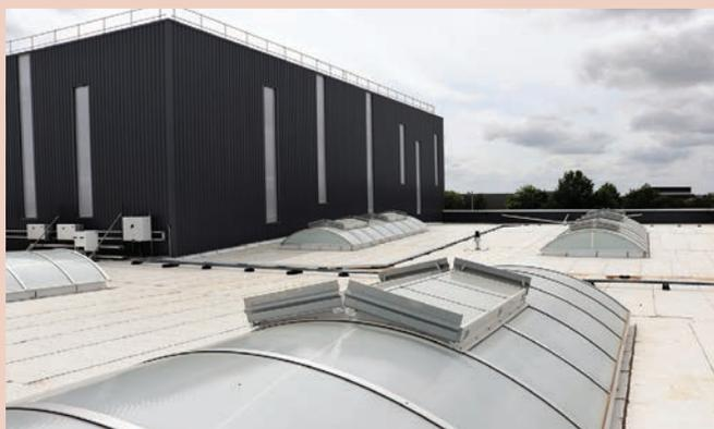
L'éclairage zénithal de l'atelier est assuré par des voûtes simples ou avec lanterneaux pilotés (pour le désenfumage et la ventilation naturelle). Le remplissage, du polycarbonate dont les alvéoles sont remplies de microbilles de silice, diffuse la lumière de façon homogène et apporte de la masse pour améliorer l'acoustique du bâtiment.
