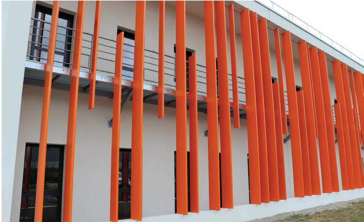
La façade des nouveaux bureaux a été agrémentée de lames de la gamme Rectiligne de 7 m de long en trois largeurs différentes. Les fixations ont été conçues pour s'adapter au bâtiment.
