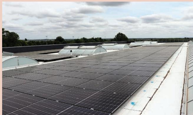
Le toit du nouveau bâtiment est une vitrine de l'offre Genatis : voûtes, lanterneaux, voiles-dômes et tours adiabatiques sont complétés ici par une production d'électricité solaire destinée à la revente (2 000 m<sup>2</sup> de panneaux photovoltaïques – une solution Soprema).
